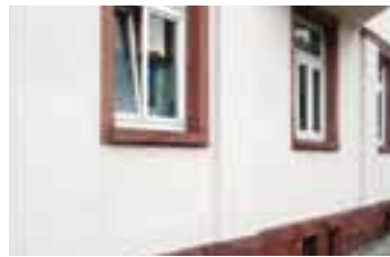
Graffiti-Entfernung und Farbrenovierung Privat/Eigentümer, Frankfurt am Main
