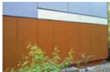
Graffiti-Entfernung und Farbrenovierung Hausverwaltung, Frankfurt am Main
